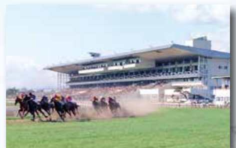
昭和45年に完成した鉄筋コンクリート3階建てのスタンド
