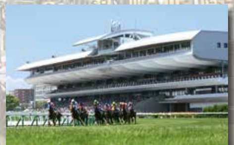
平成22年に函館競馬場新スタンドがオープン
