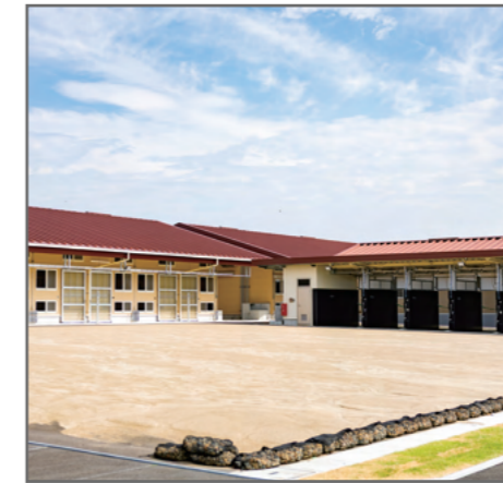
中央地区厩舎 Stable (Central Area)
